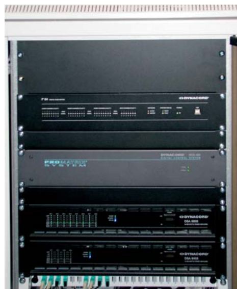
Jeden z raków z matrycą P64 i wzmacniaczami z serii DSA firmy Dynacord.
